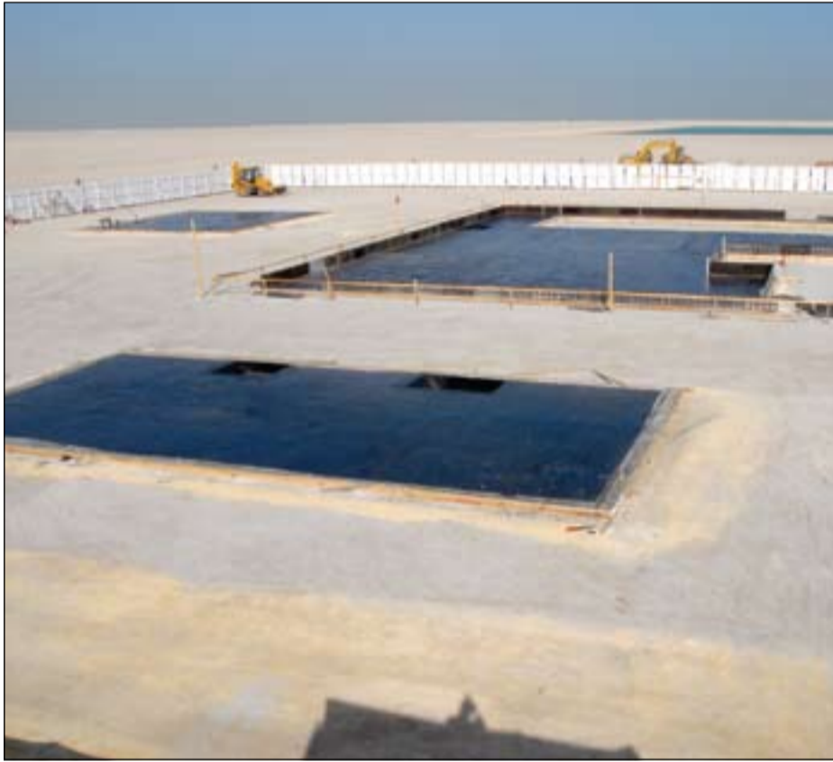
المساحة التي ستشأ عليها محطة الكهرباء الرئيسية بجهد 220 فولت
