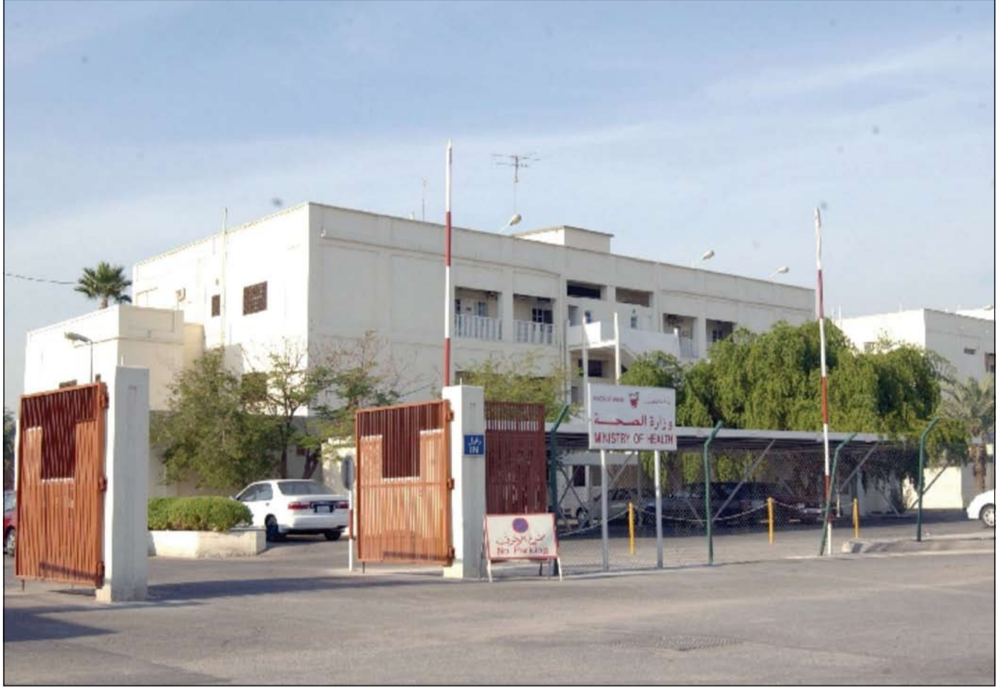
مبنى وزارة الصحة
