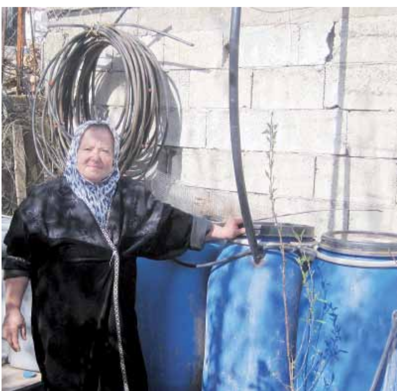
عدلي توبة ونظام معالجة المياه الرمادية من نوع الأربعة براميل خارج بيتها في عيترون بلبنان
