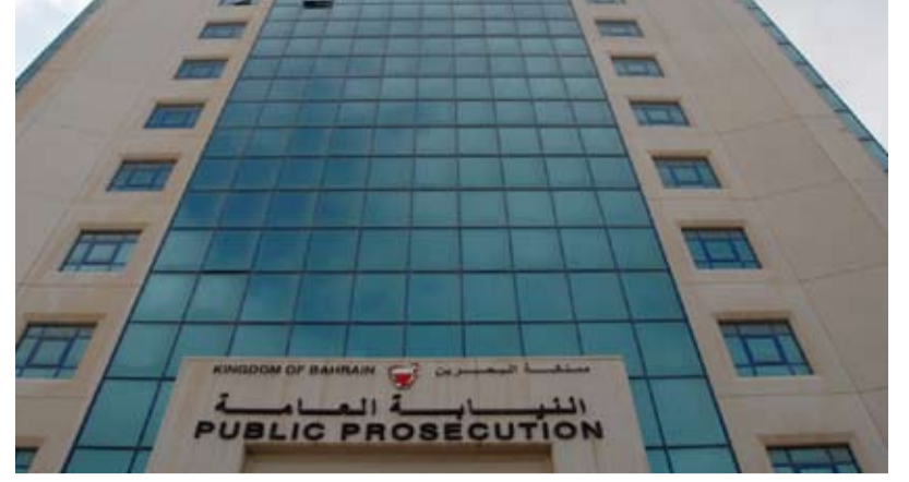
مبنى النيابة العامة
