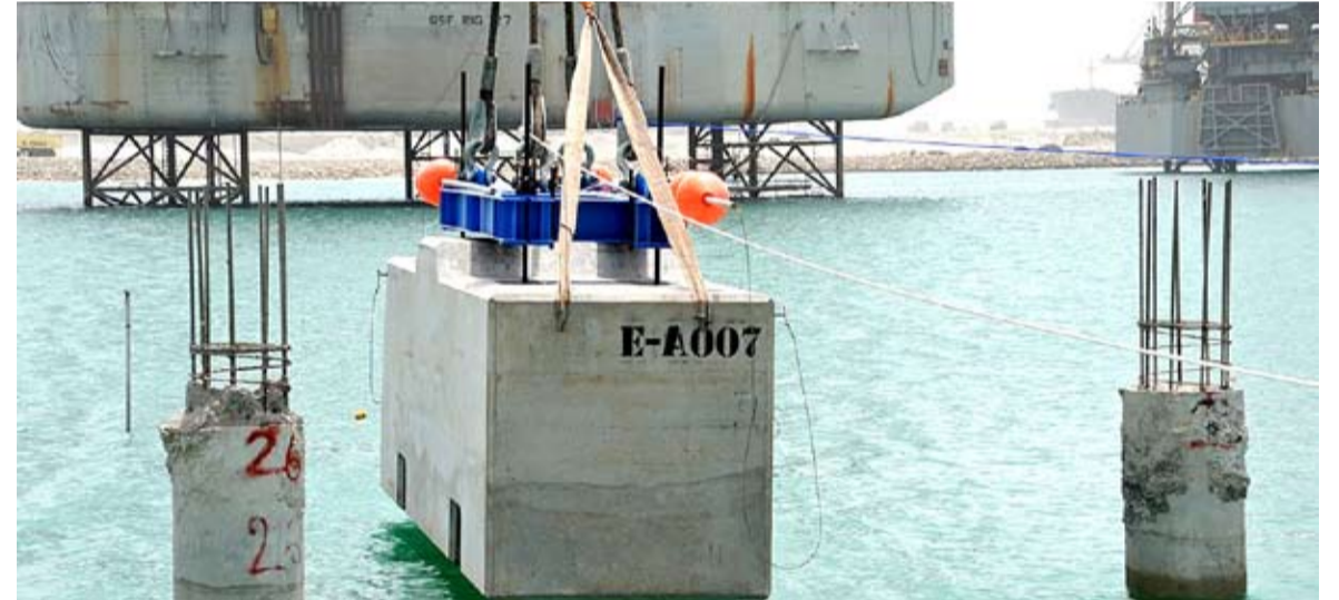
«أسري» تنفيذ مشروع إنشاء رصيف بحري بطول 1380 متراً
